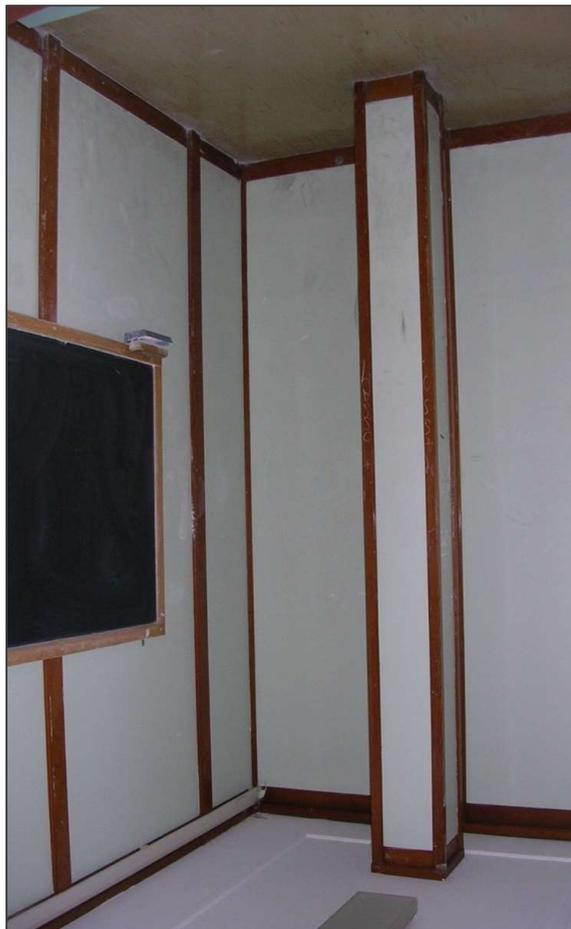
Pannelli tagliafuoco a protezione strutture acciaio
