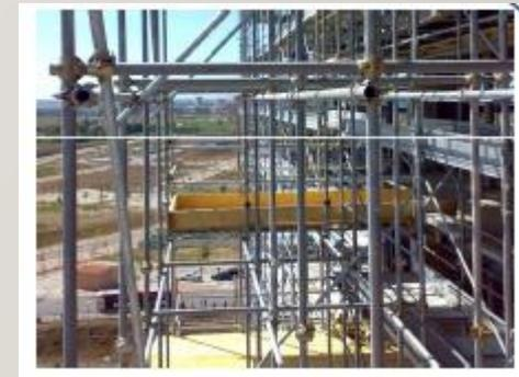
Per le sue caratteristiche di flessibilità, robustezza e manutenzione contenuta, il sistema a “tubo e giunto” è quello che, nel tempo, ha soppiantato definitivamente il sistema di ponteggio in legno.
