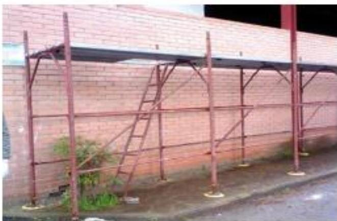
Fig. 4.1.1: Il primo impalcato di sostegno a stelo montato
